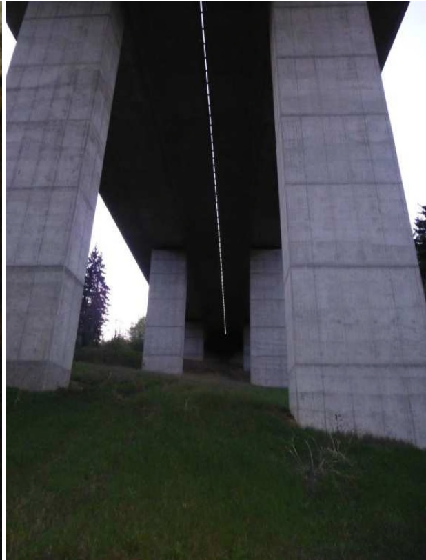
Abbildung 7 Brücke über dem Möhntal
